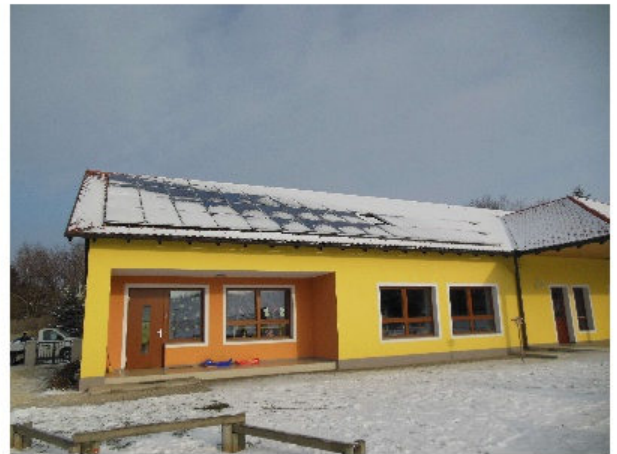
oben: Photovoltaikanlage - links: Heizung - KINDERGARTEN FALLBACH
