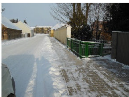
Brandbachbrücke Altmannser Straße, Hagenberg
