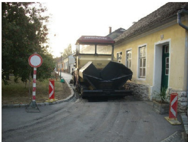
Asphaltierungsarbeiten in Hagenberg
