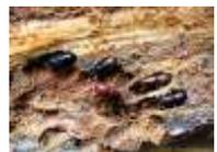
Der Befall ist an den etwa 3 mm großen Einbohrlöchern und am ausgeworfenen Bohrmehl zu erkennen.
