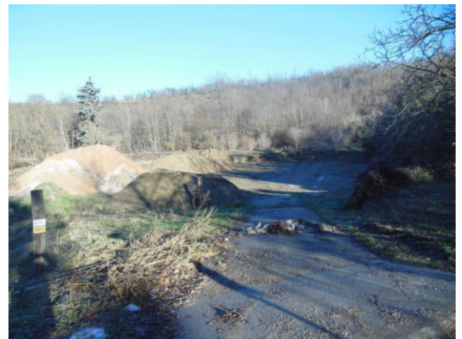
Bauplatzschaffung Loosdorf, Abbruch ehem. Gärtnerei Homolka
