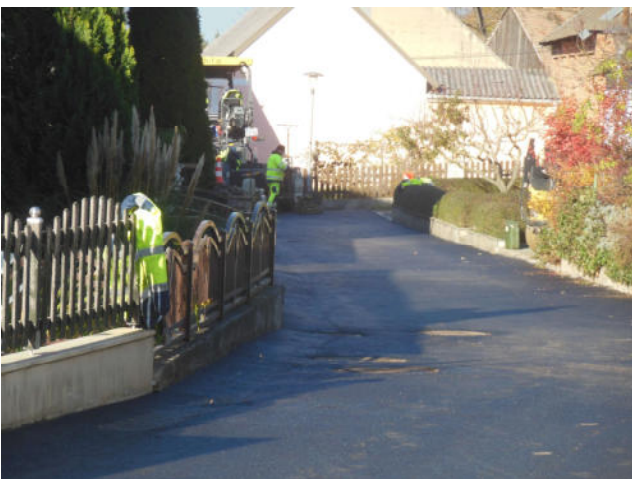
Straßensanierung Loosdorf, Kleine Zeile
