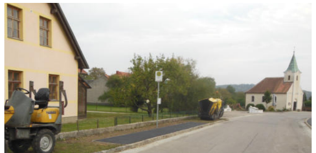
Asphaltierungsarbeiten Bushaltestelle Friebritz
